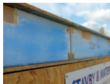
I-OSB™ jako spojovací prvek
